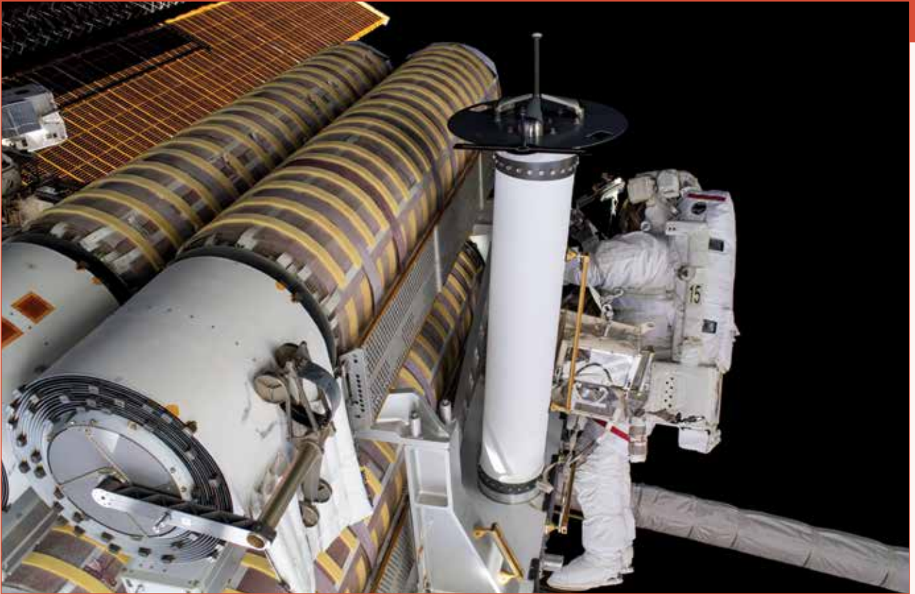
Astronaut Bowen aan het werk om de nieuwe, hier nog opgerolde, zonnepanelen op het ISS te installeren. [NASA]
