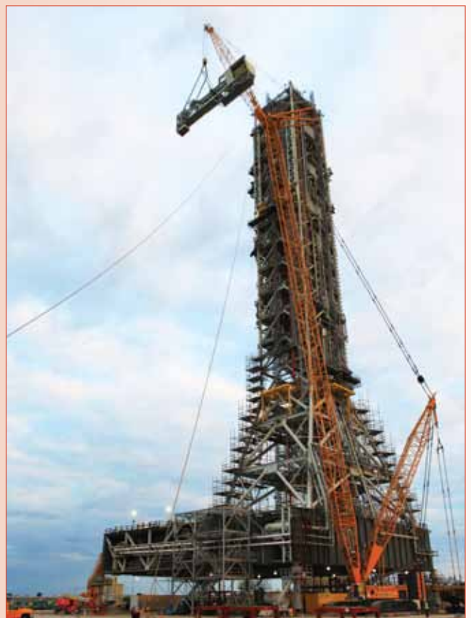
De toegangarm met de bekende White Room waardoor astronauten vanaf 2021 het Orion ruimtevaartuig zullen betreden wordt aan de 100 meter hoge lanceertoren van de SLS raket bevestigd. [NASA]
