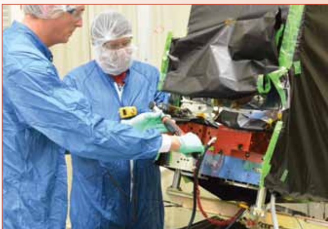
Technici vullen de tanks van een SkySat satelliet met HPGP, een milieuvriendelijk en veiliger alternatief voor hydrazine. [Bradford ECAPS]
